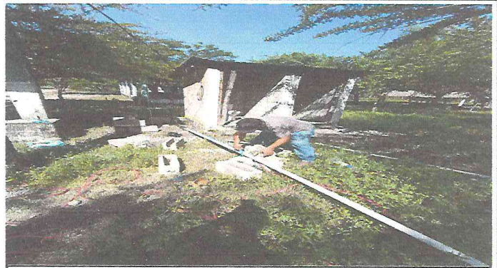
Foto 2: PROCESO DE INSTALACION DE BOMBA DE AGUA
