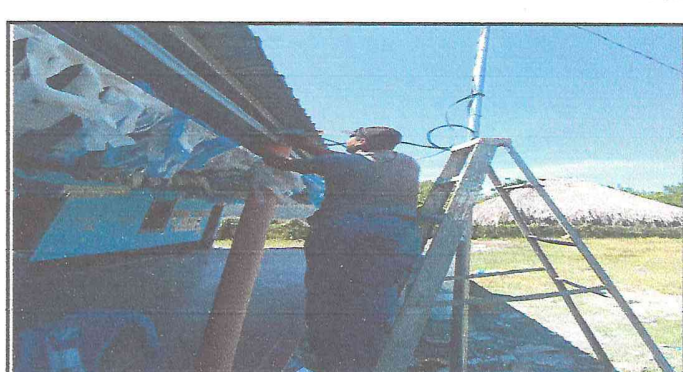
Foto 6: instalacion de energia electrica en corredor
