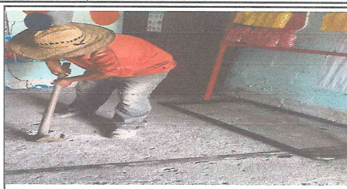
Foto 2: demolicion de torta de concreto en mal estado en aulas
