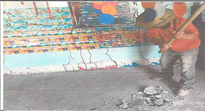
Foto 1: demolicion de torta de concreto en mal estado
