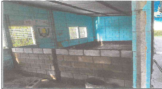
Foto 3: construccion de pared
