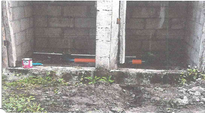
Foto 1: DURANTE LA INSTALCION DE TUBERIA PARA SANITARIOS NUEVOS
