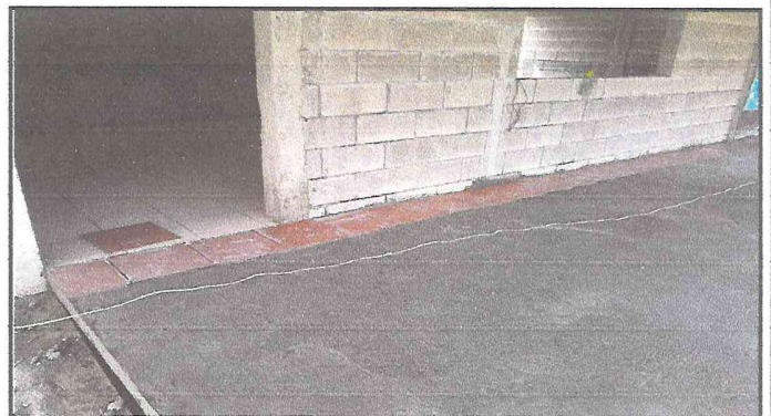
Foto 4: PROCESO DE INSTALCION DE PISO EN CORRDOR
